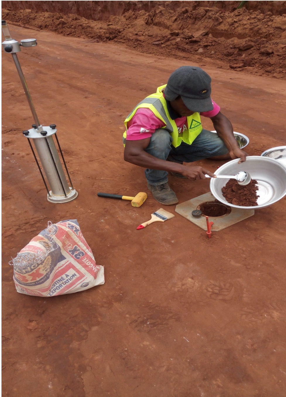
Mesure de compacité sur couche de fondation ; voirie 5 villas , Lomé (Togo)
