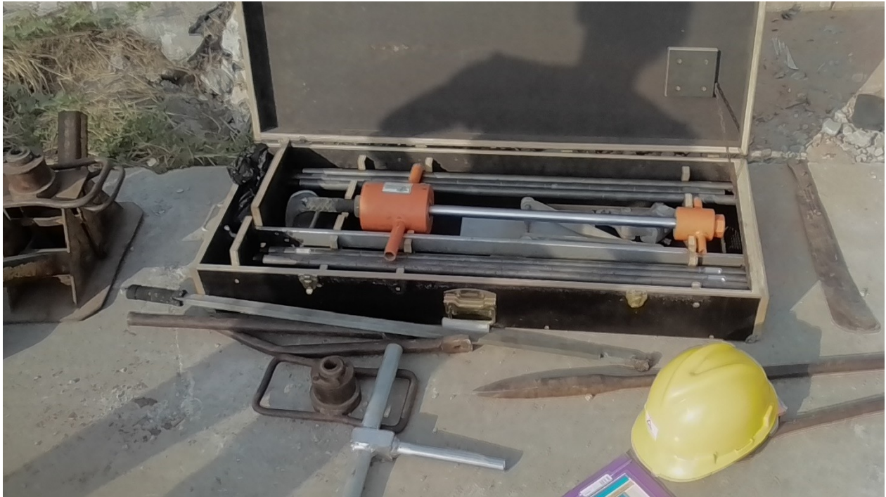
Installation du matériel sur le site de construction de la nouvelle parfumerie Ghandour dans la zone industrielle de Lomé (Togo)
