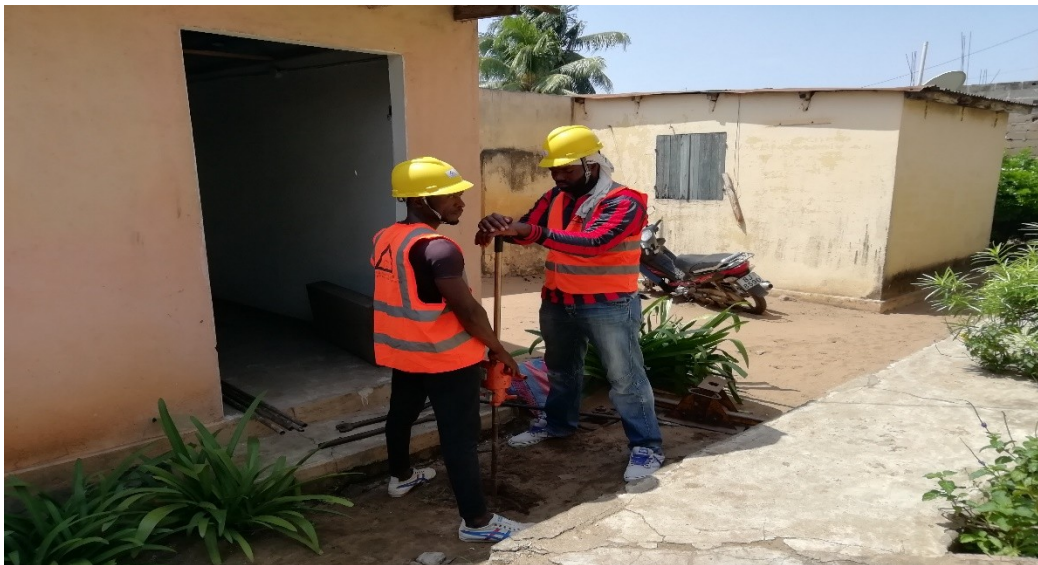
Sondage pénétrométrique sur le site de construction de la station-service de Nyekonakpoè (Togo)
