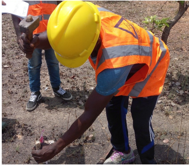
Implantation de points d'essais sur le site de construction de l'usine de fabrication de bouteilles de gaz de Blitta (Togo)
